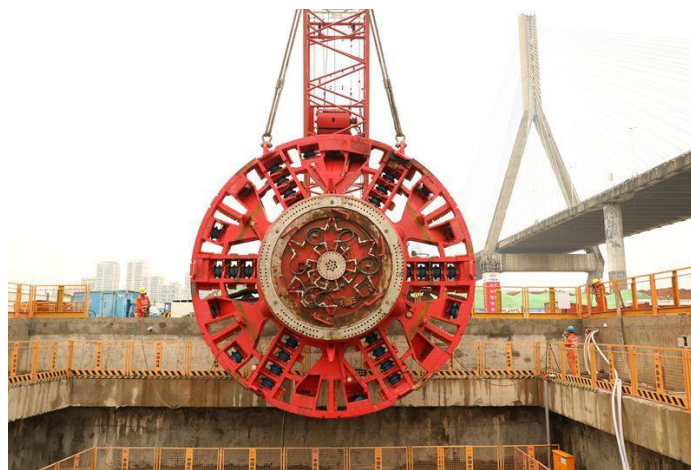
盾构机吊装示意图
