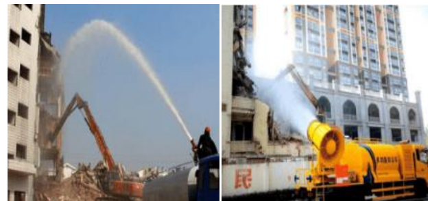
拆除工程喷水措施
