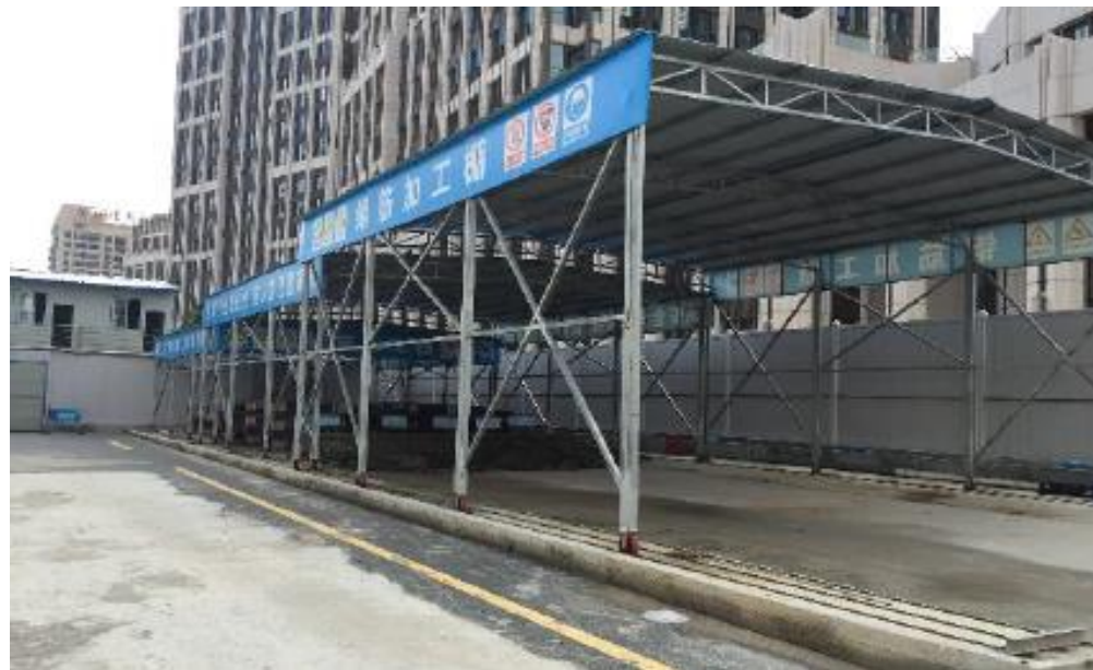
工具式钢筋加工场（地铁项目）
