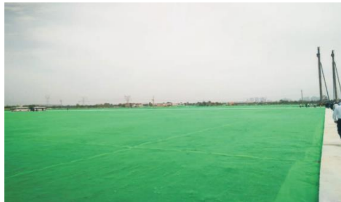
工程土渣、建筑垃圾绿网覆盖
