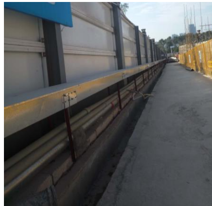
电缆线沿墙壁敷设示意图
