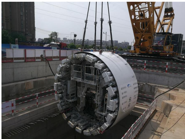
盾构机吊装示意图
