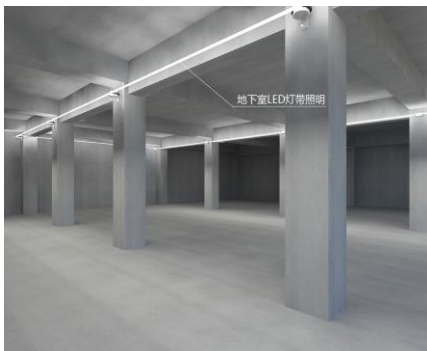
地下室LED灯带照明示意图
