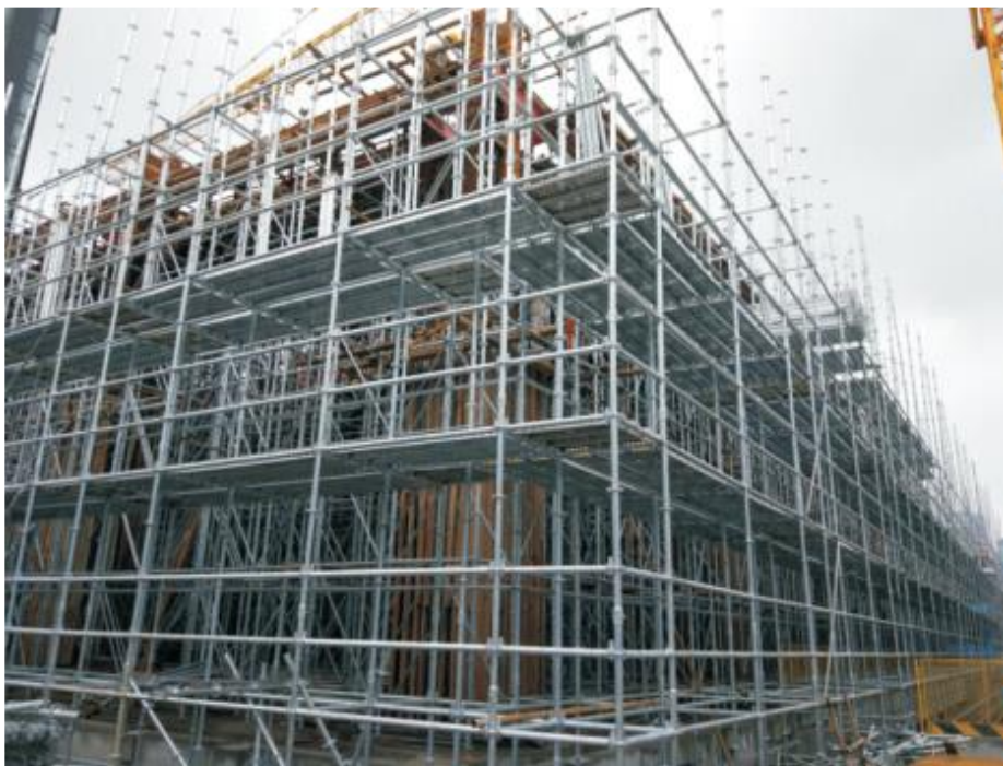
盘扣式脚手架搭设示意图
