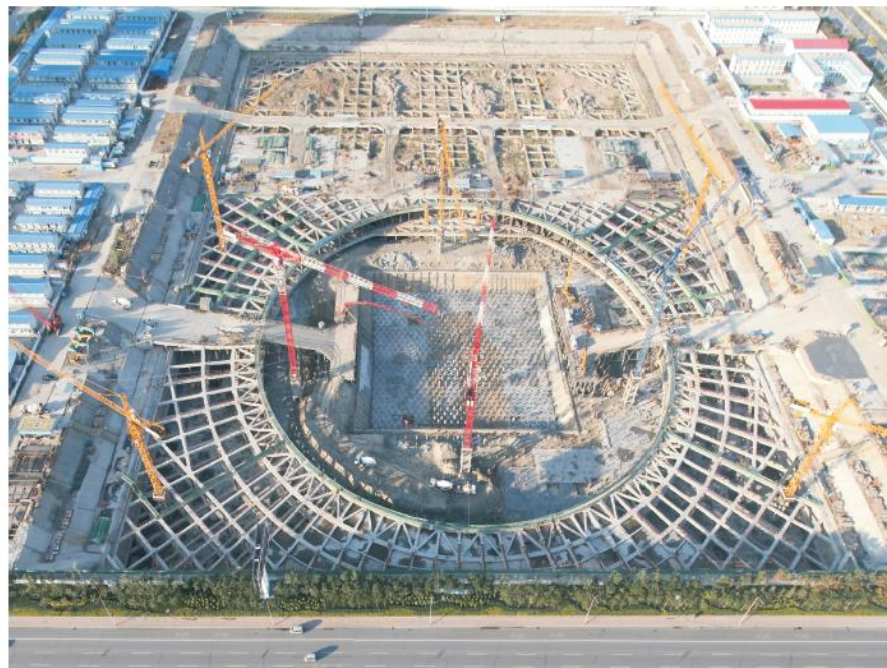
基坑支护示意图
