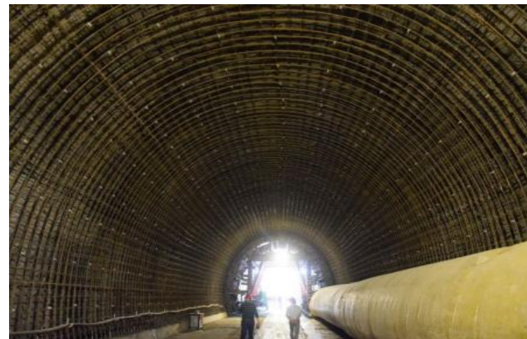
拱桥钢筋绑扎成型
