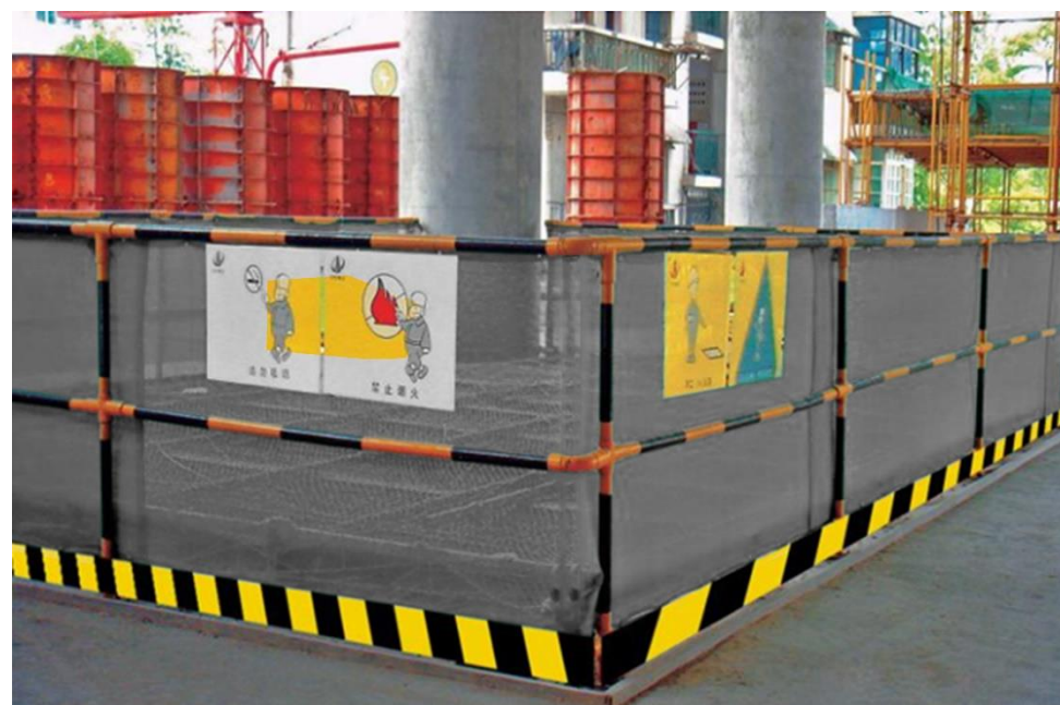
钢管搭设式防护栏杆
