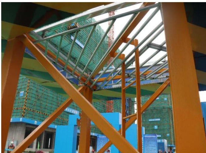
塔吊防攀爬装置
