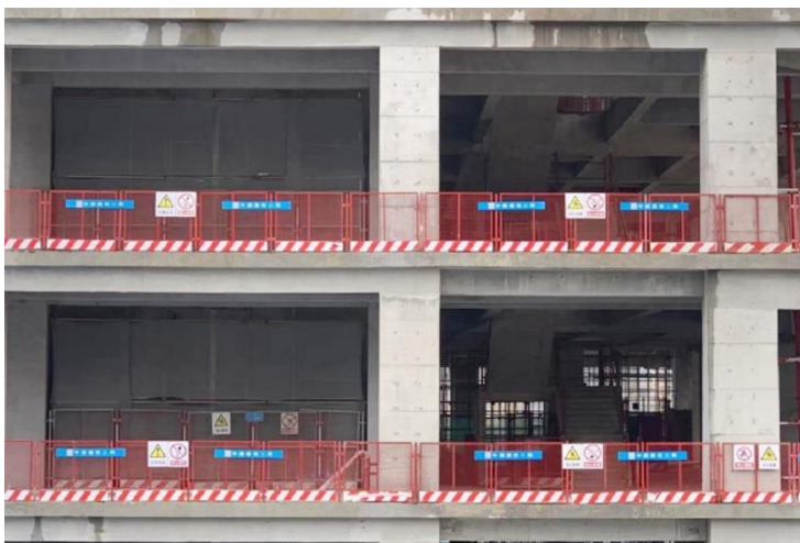
楼层临边定型化防护实景图
