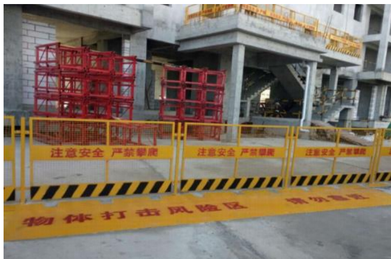
防坠区域隔离防护实景图（二）
