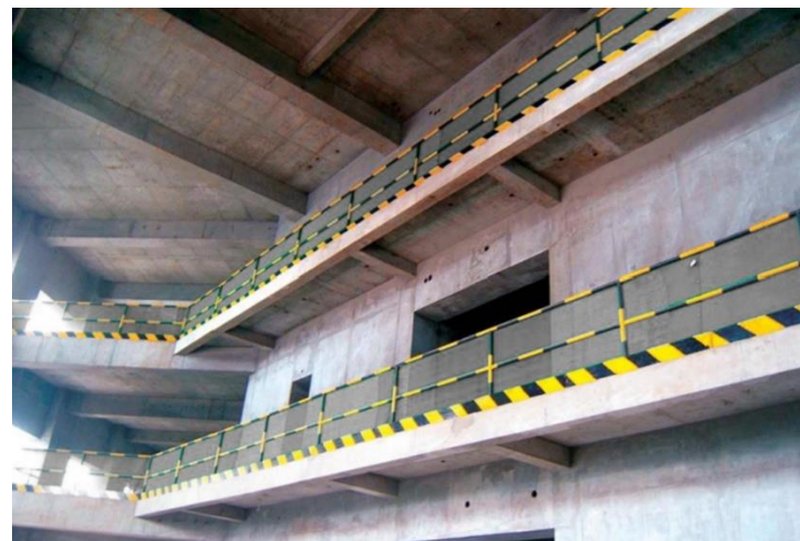
楼层临边钢管防护实景图
