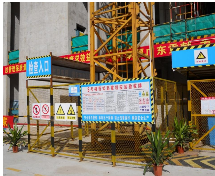
塔吊底部防护栏杆
