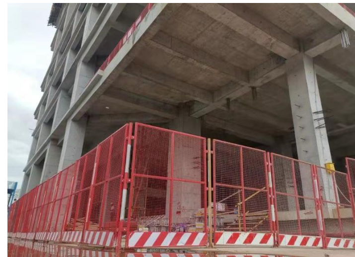
防坠区域隔离防护实景图（一）
