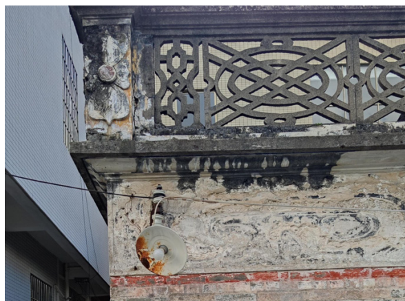
灰塑构件缺失缺损
