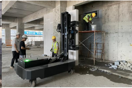
安装机器人现场图
