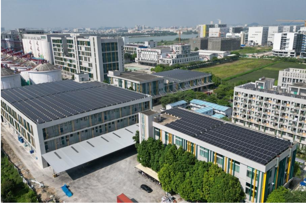
岭南穗粮谷物公司绿色低碳园区建设项目一期项目现场图
