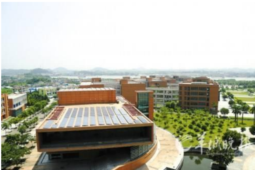
光伏发电项目
