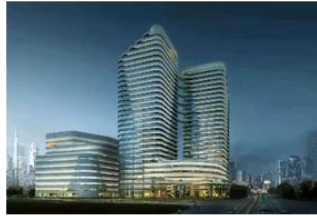
佛山农信数据中心
