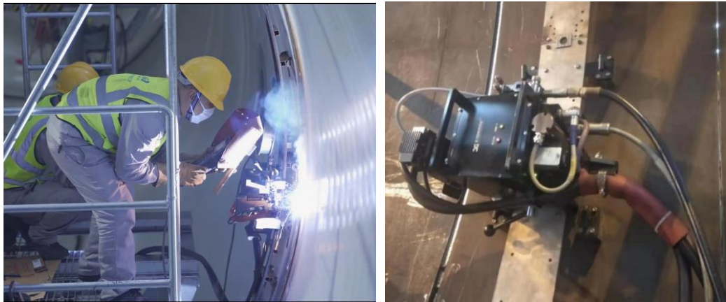
大直径内衬钢管单面焊双面成形全位置自动焊接工艺及轨道式焊接机器人
