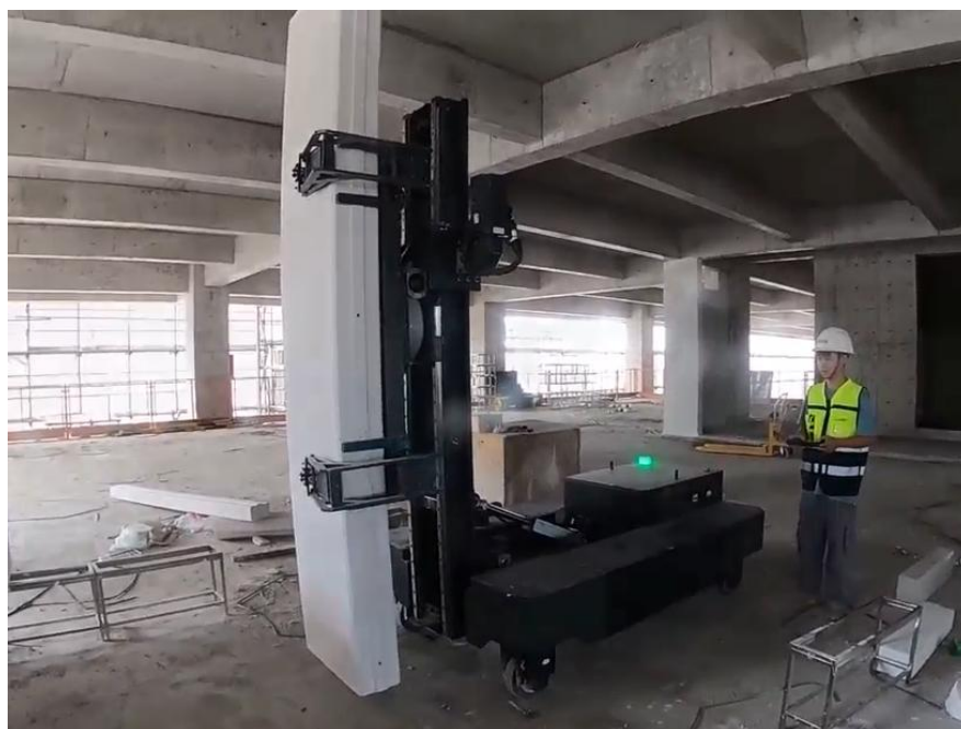
条板安装机器人现场应用
