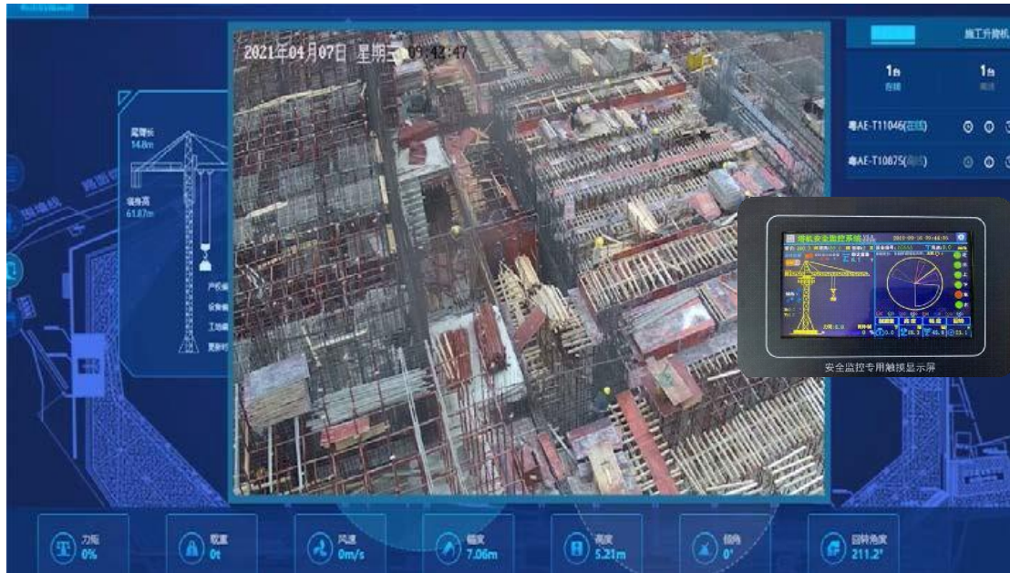
塔机安全监控
