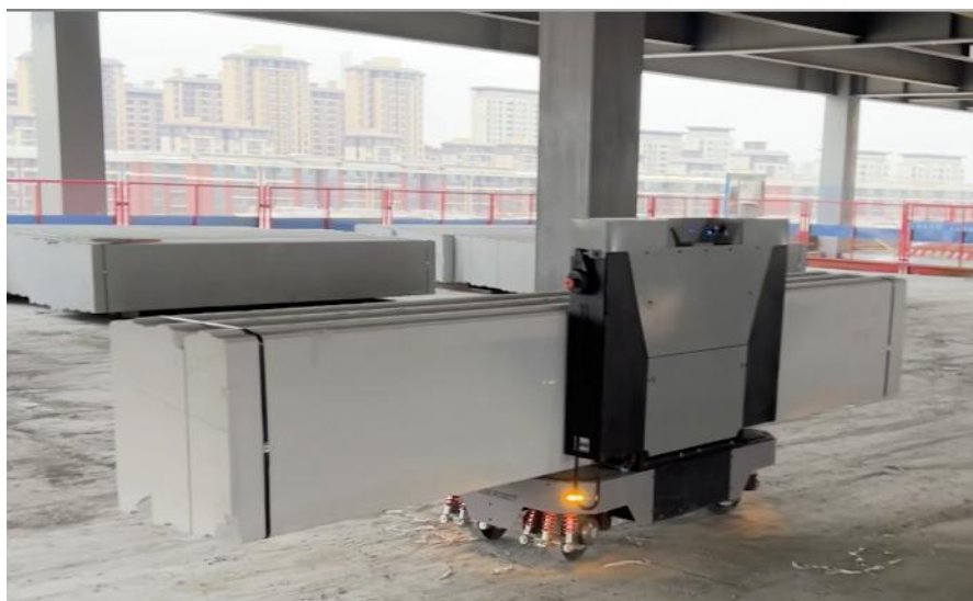
条板搬运机器人现场应用
