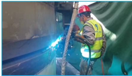
“爬壁焊接机器人”
