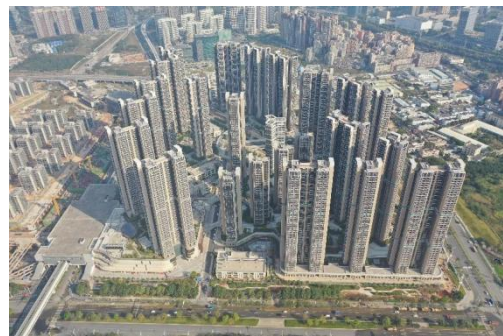
深圳长圳公共住房项目
