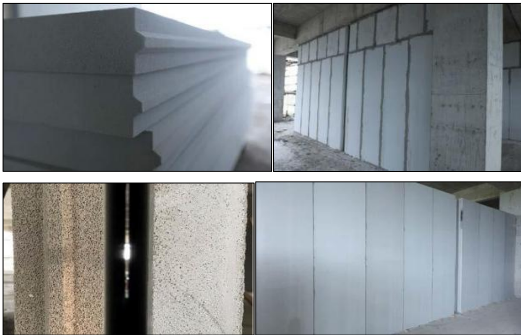
发泡陶瓷隔墙施工
