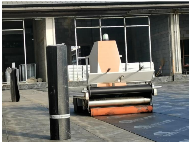
防水卷材机器人现场应用
